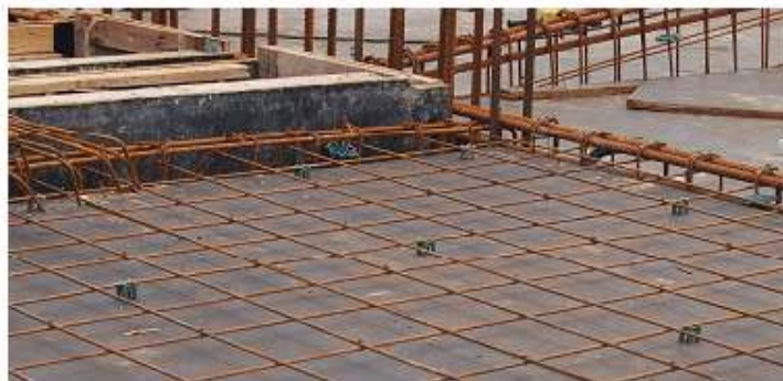
Figura 9 – Espaçadores de plástico, tipo cadeirinha, nas lajes
