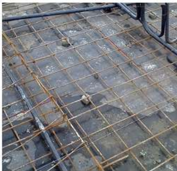
Figura 8 – Espaçadores de argamassa nas lajes
