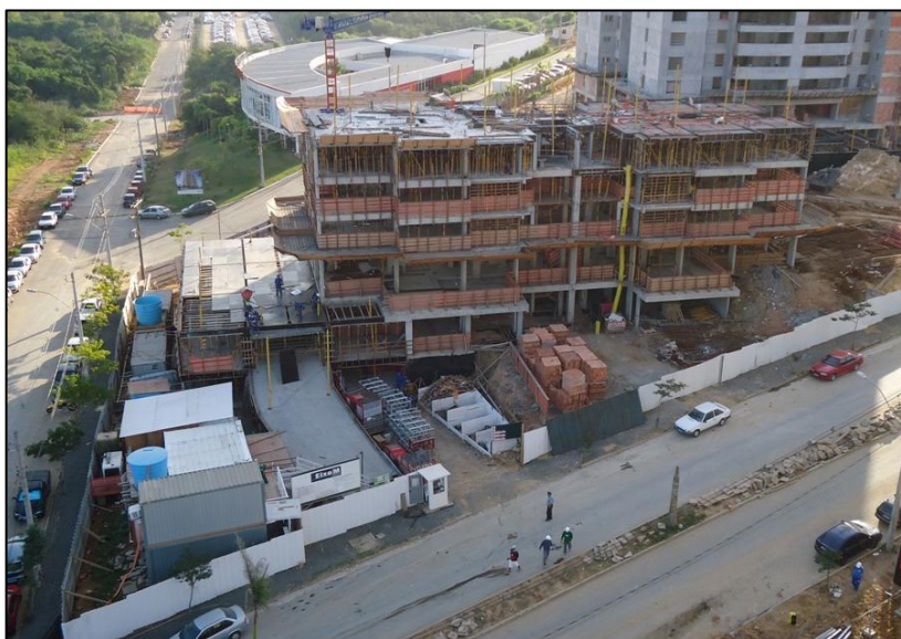
Figura 12 – Logística do canteiro de obra
