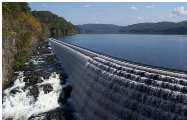
Figura 11: Barragem de New Croton, EUA, construída entre 1892 e 1906 (fonte: http://www.etsy.com/listing/52313172/the-new-croton-dam )
