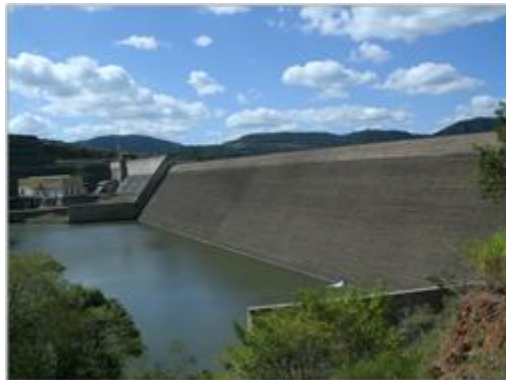
(c) Vertedouro em degraus na Barragem Dona Francisca, Agudo/RS
