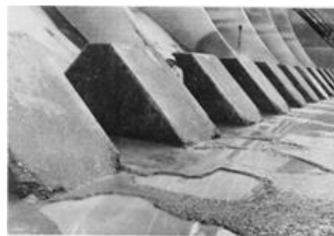
Figura 4: Cavitação em blocos na entrada da bacia. (a) UHE Salto Grande, Argentina (fonte: notas de aula do Prof. Marcelo Marques) e (b) Barragem de Bonneville, (fonte: Lopardo et al. 2006)
