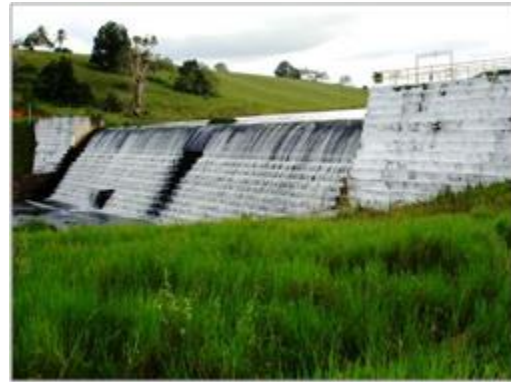
(b) Vertedouro em degraus na Barragem Rio da Dona, Stº Antônio de Jesus/BA
