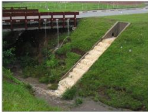
(a) Degraus a jusante de bueiro
