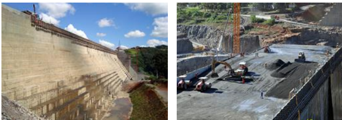
Figura 12: Barragem da usina Hidrelétrica de Mauá durante a construção, 2010 (fonte: http://www.aen.pr.gov.br/modules/noticias/article.php?storyid=62750&tit )
