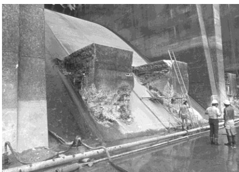
Figura 4: Cavitação em blocos na entrada da bacia. (a) UHE Salto Grande, Argentina (fonte: notas de aula do Prof. Marcelo Marques) e (b) Barragem de Bonneville, (fonte: Lopardo et al. 2006)
