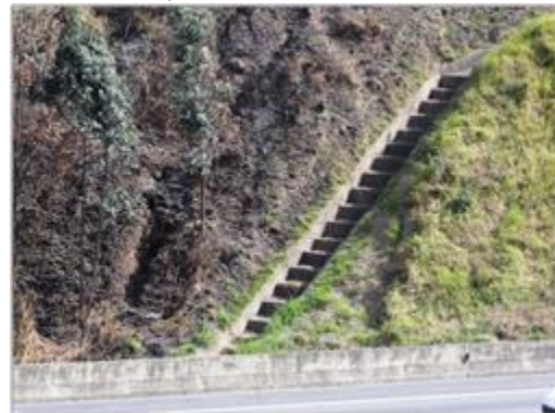
(d) Canal em degraus em encosta
