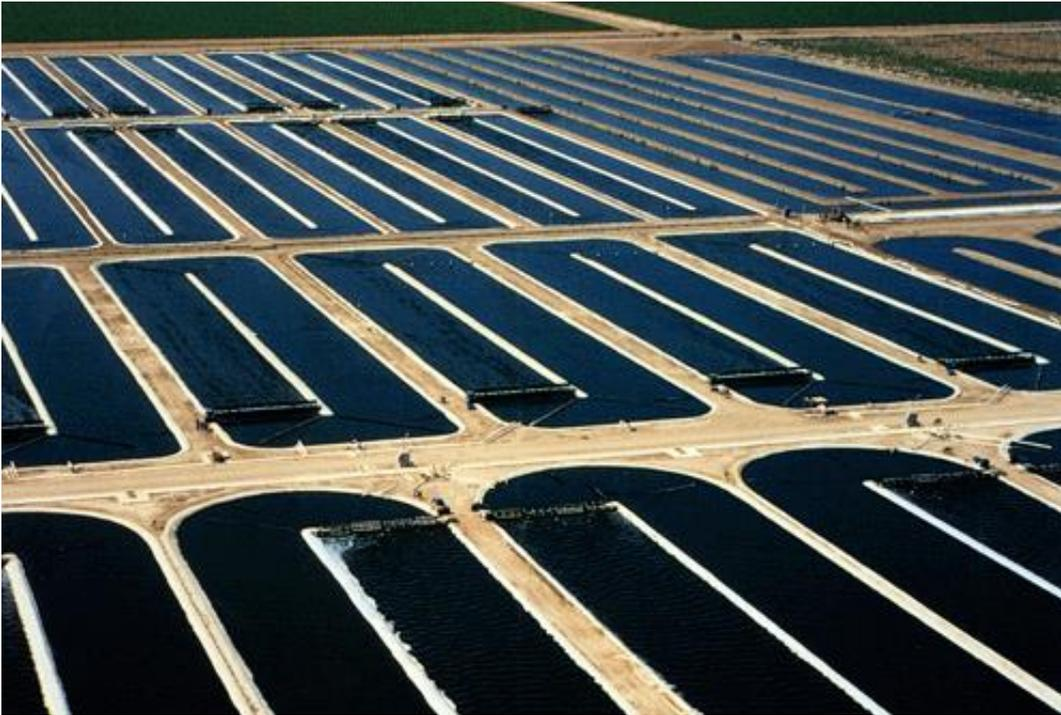
**Figura 2.5:** Modelo de Raceway utilizado pela empresa Earthrise no deserto de Sonoran, no sudeste da Califórnia, Estados Unidos - Imagem do site earthrise.com, acessado em 25/09/2014
