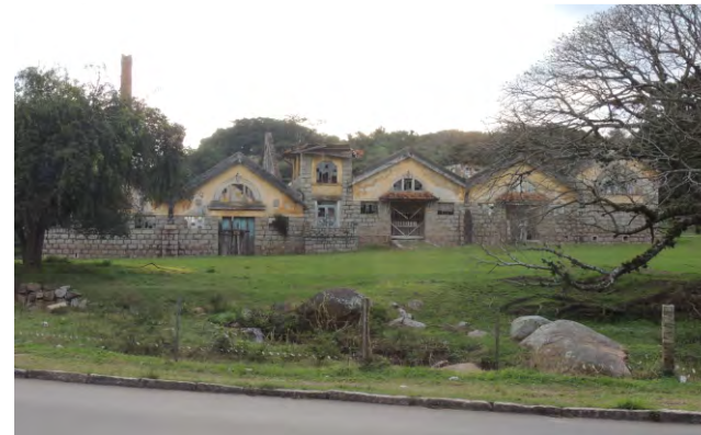
Vista 03- Matadouro São Geraldo
