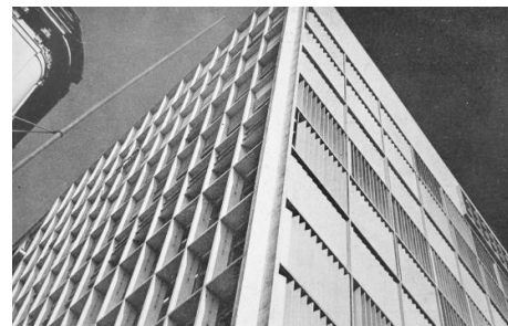
Figura 139: Convergência entre as faces norte e oeste do Edifício-Sede do Banco Boa Vista, demonstrando o emprego de brise-soleil em suas múltiplas variantes. Fonte: Habitat, n. 42/43 (Aôût 1952), p. 43.
