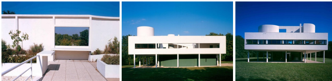
Figuras 56, 57 e 58: Terraço-jardim e fachadas da Villa Savoye.
