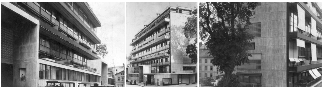
Figuras 83, 84 e 85: Vista da fachada frontal do Immeuble Clarté, em Genebra; vista a partir da esquina, onde estão posicionadas as salas comerciais e vista aproximada da fachada posterior. Fonte: www.fondationlecorbusier.fr
