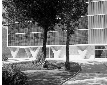
Figura 194: Vista da elevação noroeste, com os pilares em "V" que caracterizam o edifício, os cobogós cerâmicos e os quebra-sóis verticais em alumínio para a proteção dos panos envidraçados. Fonte: www.niemeyer.org
