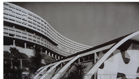
Figura 143: Vista do Bloco A, em segundo plano, e do ginásio, em primeiro plano.
