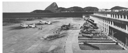
Figura 107: Vista geral do Aeroporto Santos Dumont. Marcelo e Milton Roberto.
