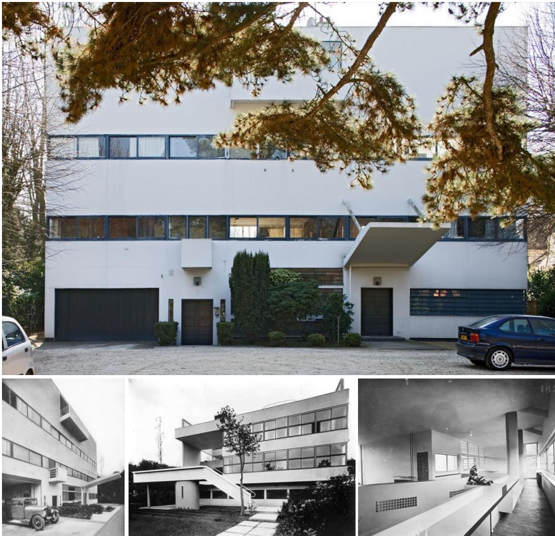
Figuras 39, 40, 41 e 42: Vistas da fachada frontal, fachada de fundos e interior da Villa Stein-de Monzie,
