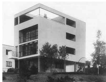
Figura 226: Vista da Maison Weissenhof-Siedlung, em Stuttgart.
