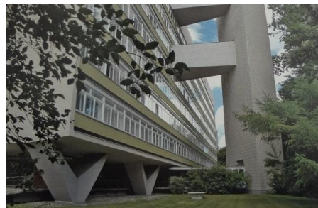
Figuras 289, 290 e 291: Pilotis do Hospital Sul América, da Fundação Getúlio Vargas e do edifício proposto para Interbau, em Berlim. Fontes: www.flickr.com ; www.niemeyer.org e PHILIPPOU, 2008, p.156.
