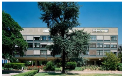
Figuras 81 e 82: Vistas do Pavilhão Suíço a partir da fachada posterior e frontal, pela qual ocorre o ingresso principal.
