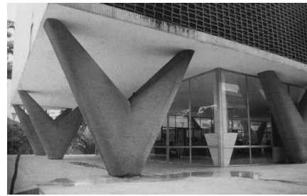
Figuras 252, 253, 254 e 255: Galeria de entrada e detalhe da elevação oeste da Obra do Berço. Vista do embasamento do Banco Boa Vista desde o encontro da Praça Pio X e Rua da Quitanda. Térreo do Hospital Sul América. Modificado de: UNDERWOOD, 1994, p. 33; PHILIPPOU, 2008, p.77; INSTITUTO TOMIE OHTAKE. 2007, p. 110; UNDERWOOD, 1994, p. 72.
