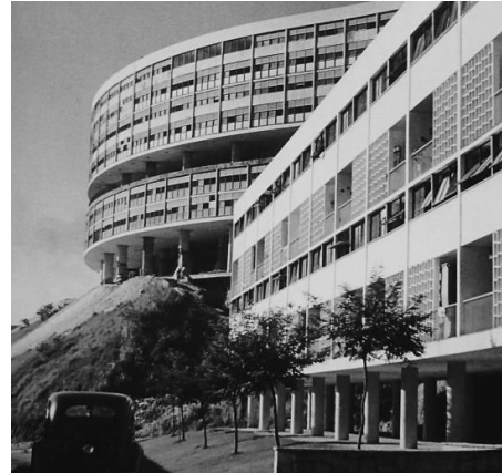
Figura 150: Vista da fachada frontal de um Bloco Residencial B, em primeiro plano, e do Bloco Residencial A, em segundo plano. Fonte: INSTITUTO LINA BO E P. M. BARDI. Afonso Eduardo Reidy. Lisboa: Blau, 2000, p. 91.
