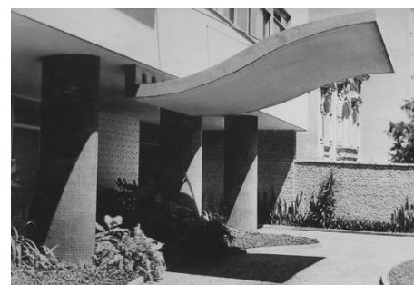
Figura 125: Vestíbulo sob pilotis, precedido pela marquise de entrada. Fonte: CZAJKOWSKI, Jorge. Jorge Machado Moreira. Rio de Janeiro: Prefeitura Municipal do Rio de Janeiro, Centro de Arquitetura e Urbanismo do Rio de Janeiro, 1999, p. 72.
