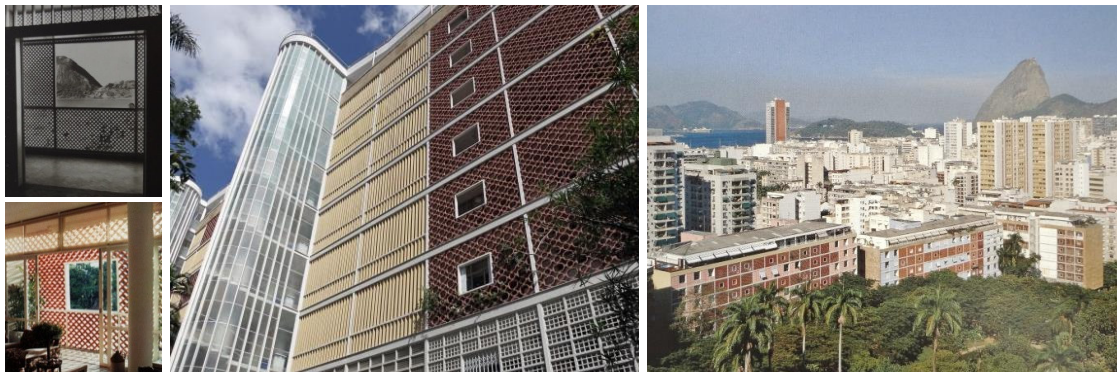
Figuras 279, 280, 281 e 282: Perspectiva interna da varanda do Edifício Antônio Ceppas, de Jorge Moreira. Perspectiva interna da varanda, conjugada à sala, de um apartamento no Parque Guinle. Vista da elevação noroeste do Edifício Nova Cintra (1948) e perspectiva do conjunto. Fontes: CZAJKOWSKI, 1999, p. 76; www.archdaily.com.br , www.archdaily.com e Philippou, 2008, p. 73.
