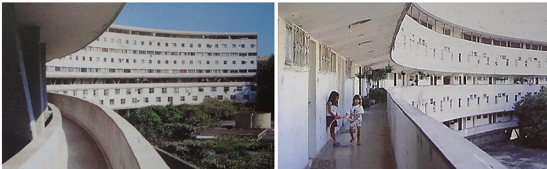
Figuras 209 e 210: Vista da elevação frontal desde o pavimento intermediário. Vista da elevação posterior desde o corredor.
