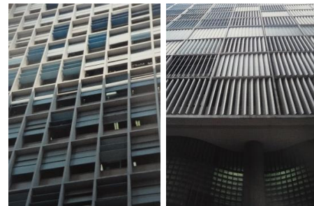
Figuras 274 e 275: Tratamento das elevações norte, análoga à do MESP, e oeste do Banco Boa Vista. Fonte: PHILIPPOU, 2008, p. 131.
