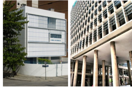
Figuras 272 e 273: Obra do Berço: vista desde a convergência entre a R. Cícero Góis Monteiro e Av. Epitácio Pessoa. Ministério da Educação e Saúde Pública: Tratamento da face norte. Modificado de: www.inepacnovo.rj.gov.br/ e www.archdaily.com.br
