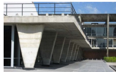
Figuras 238, 239, 240, 241, 242 e 243: Pilotis em “V” do pavimento intermediário em concreto bruto da Gávea. Pilotis em “V” do Hospital Sul América. Pilaretes que suportam a marquise da Cité de Refuge. Elementos estruturais do bloco de exposições do Museu de Arte Moderna do Rio de Janeiro. Pilotis da Unité d’Habitation, de Le Corbusier. Pilares do Teatro do Museu de Arte Moderna do Rio de Janeiro. Modificado de: www.moradiapopularnobrasil.com.br ; CAVALCANTI, 2013, p. 119; www.fondationlecorbusier.fr ; www.archdaily.com.br ; www.fondationlecorbusier.fr e www.archdaily.com.br .
