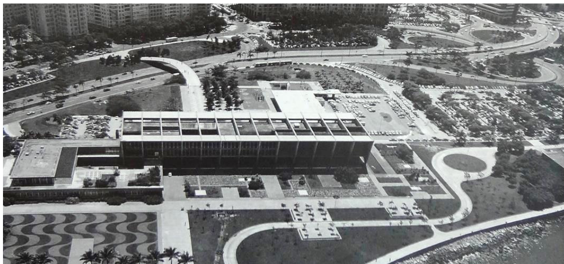
Figura 213: Vista do Museu de Arte Moderna do Rio de Janeiro e sua inserção no entorno urbano e na paisagem natural.
