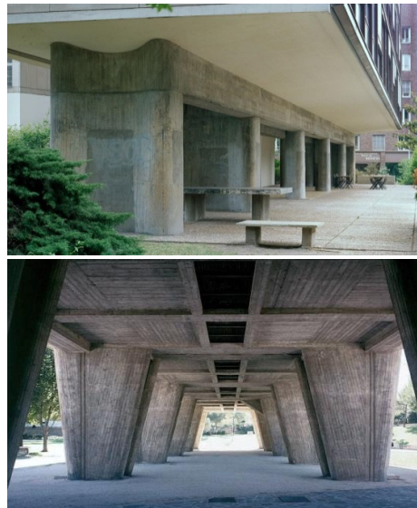
Figuras 287 e 288: Pilotis do Pavilhão Suíço, em Paris e da Unité d'Habitation, em Marselha. Fontes www.fondationlecorbusier.fr
