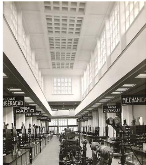
Figura 48- Vista interna do Edifício Mesbla Veículos (1944), São Paulo, Brasil.
