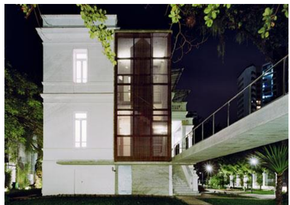
Figura 135- Vista lateral do palacete com a passarela e volume de aço corten que conecta a pré-existência com a nova edificação.
