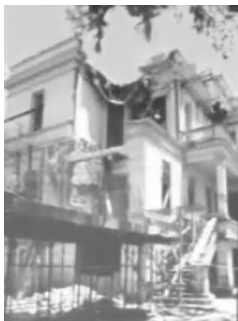
Figura 147- Quina do palacete preparada para intervenção. Fonte: Palestra Ferraz (2010).
