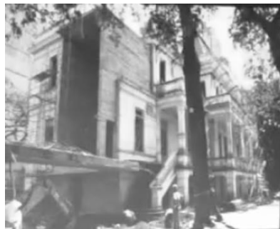
Figura 148- Construção da conexão palacete e novo edifício. Fonte: Palestra Ferraz (2010).
