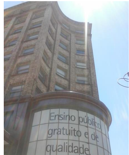
Figura 53- Vista entrada principal do Edifício Magazine Mesbla (1944), Porto Alegre, Brasil. Fonte: Luíza Ludwig Loder.
