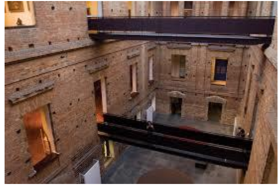
Figura 125- Vista interna clarabóia e passarelas do pátio interno.
