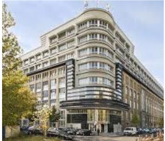
Figura 18- Reforma da Rudolf-Mosse-Haus na Jerussalemerstrasse e Schutzentrasse, (1923), Berlim, Alemanha, Arq. Erich Mendelsohn, Richard Neutra e R.P. Henning. Fonte: www.german-architecture.info
