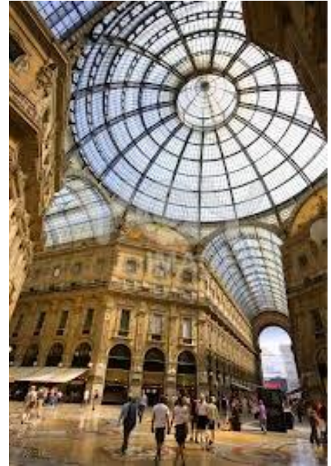
Figura 55- Galeria Vitória Emanuele II, Arq. Giuseppe Mengoni (1865-77), Milão, Itália.
