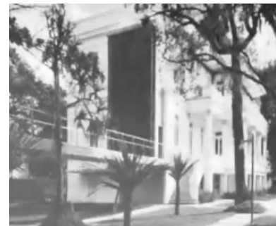
Figura 149- Conexão da preexistência e novo edifício executada. Fonte: Palestra Ferraz (2010).
