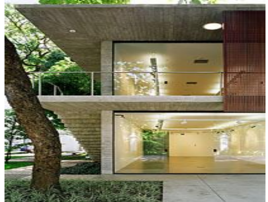
Figura 137- Edificação nova proposta por Ferraz que compõe o conjunto do Museu Rodin. Fonte: www.brasilarquitectura.com .
