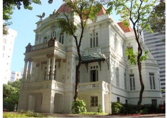
Figura 136- Palacete preexistente, base para a rearquitectura de Ferraz. Fonte: www.brasilarquitectura.com .
