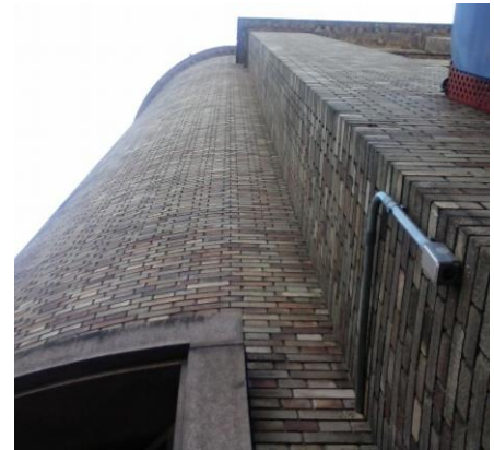
Figura 54- Vista entrada principal do Edifício Mesbla Veículos (1944), Porto Alegre, Brasil. Fonte: Luíza Ludwig Loder.
