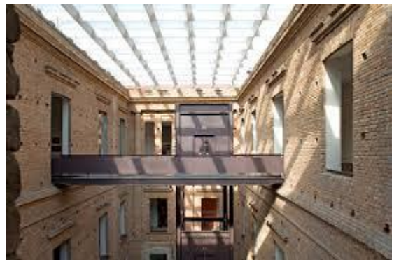
Figura 126- Vista pátio interno com passarelas.
