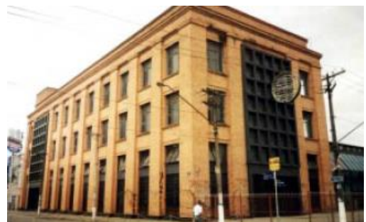
Figura 44- Vista externa do Edifício Mesbla Veículos (1944), São Paulo, Brasil.
