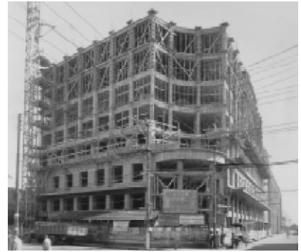
Figura 65- Construção do átrio com destaque para secagem das estruturas em concreto e ancoragem com madeira pinus(s.d.). Fonte: Canez (2006).
