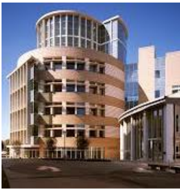
Figura 20- Universidade do Texas A&M - Edifício Instituto Mitchell - Departamento da Física e Astronomia (2009), Texas, EUA, Arq. Michael Graves. Fonte: www.masonrysystems.org
