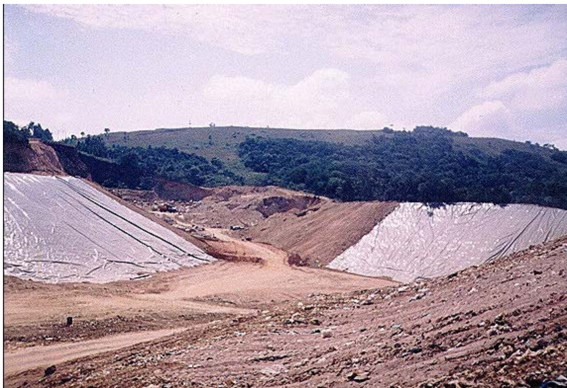
Figura 2.10 – Vista da impermeabilização do aterro. Fonte DMLU.
