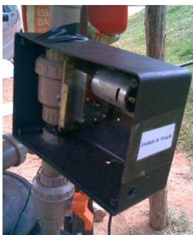
Figura 4.9 – A válvula de entrada de ar semi-automática.
