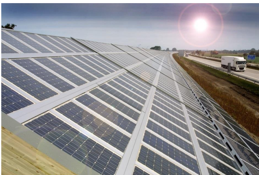
Figura 2.2 Painel de revestimento em porcelanato equipado com células fotovoltaicas (BERTO 2006).
