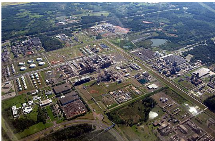
Figura 2.2: Vista aérea do Polo Petroquímico de Triunfo (Fonte: Portoimagem, 2012).
