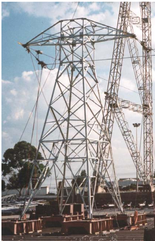
Figura 6.5: Ensaio de protótipo na torre “1”.
