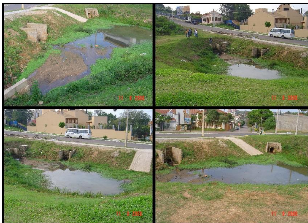
Figura 7 – Bacia de detenção em funcionamento
