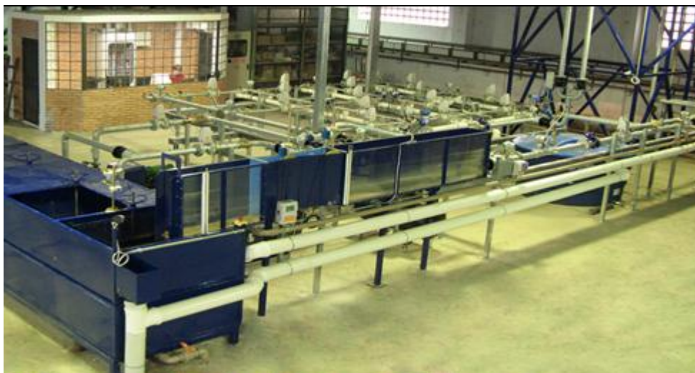
Figura 4 – Vista geral da bancada fixa do Laboratório de Eficiência Hidráulica e Energética
