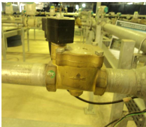
Figura 8 – Válvula solenoide Jefferson 1342BA12
