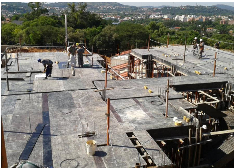
Figura 33 – Assoalho da laje
