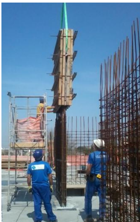
Figura 17 – Locação dos pilares em pavimento ímpar
