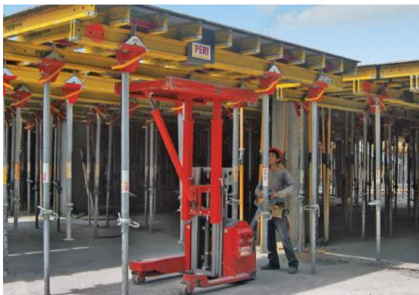
Figura 12 – Equipamento para desforma e movimentação das mesas
