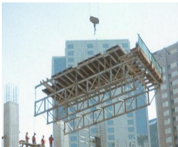
Figura 9 – Movimentação de mesa voadora
