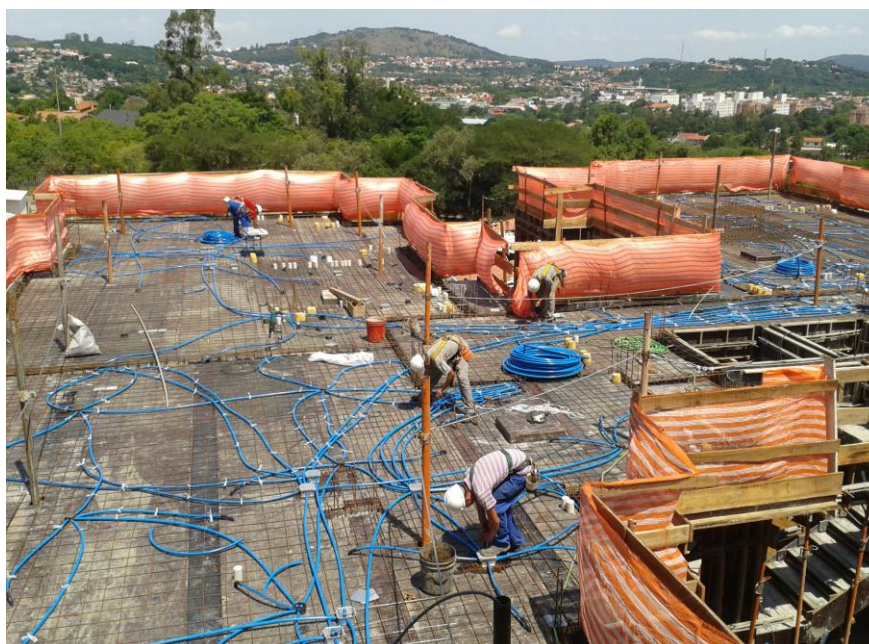
Figura 35 – Instalações elétricas
