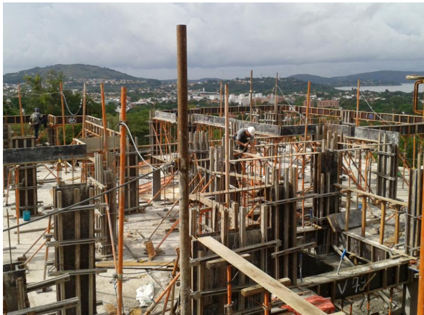
Figura 32 – Painéis internos e fundos de vigas
