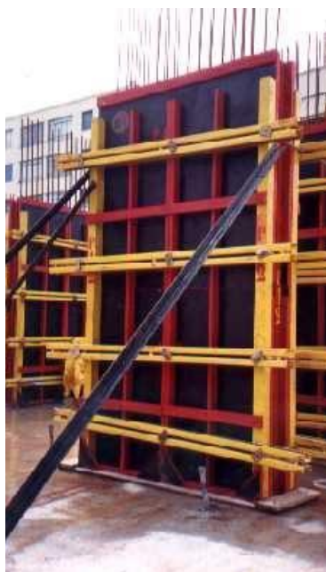
Figura 4 – Sistema tramado para fôrmas de pilares
