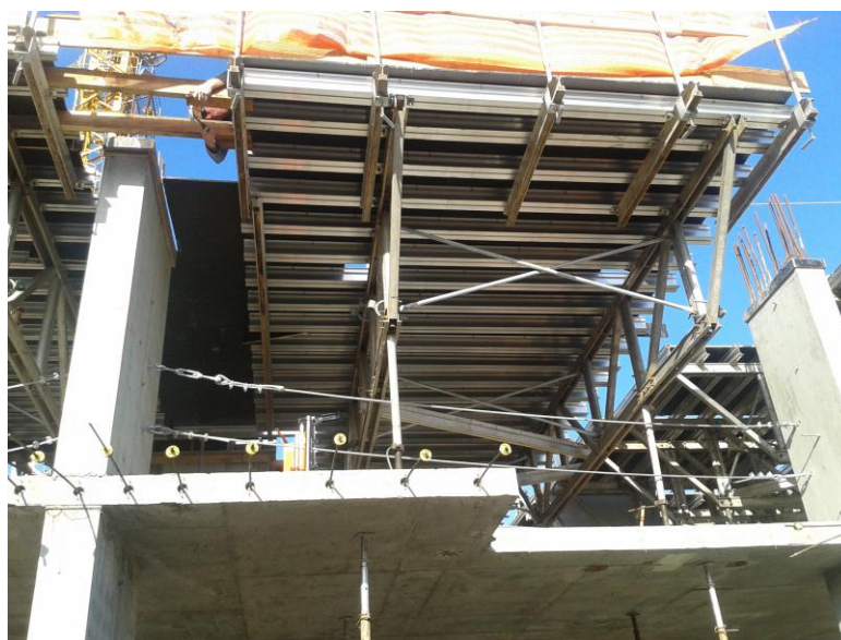
Figura 19 – Arremates entre as mesas
