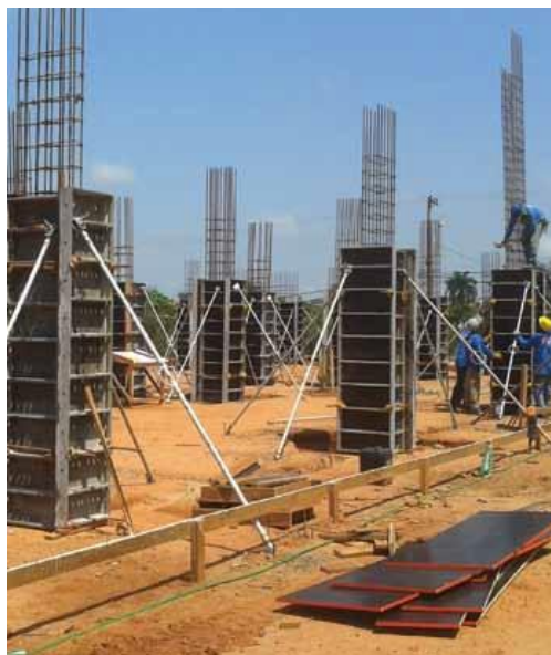
Figura 5 – Sistema modular para fôrmas de pilares
