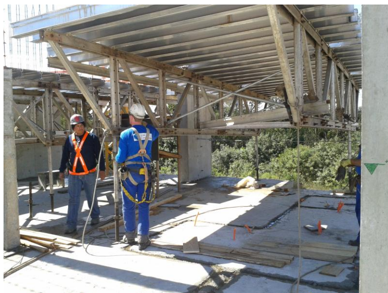
Figura 24 – Colocação das hastes de base
