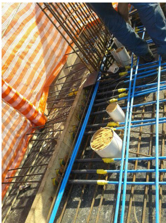
Figura 25 – Colocação das cordoalhas
