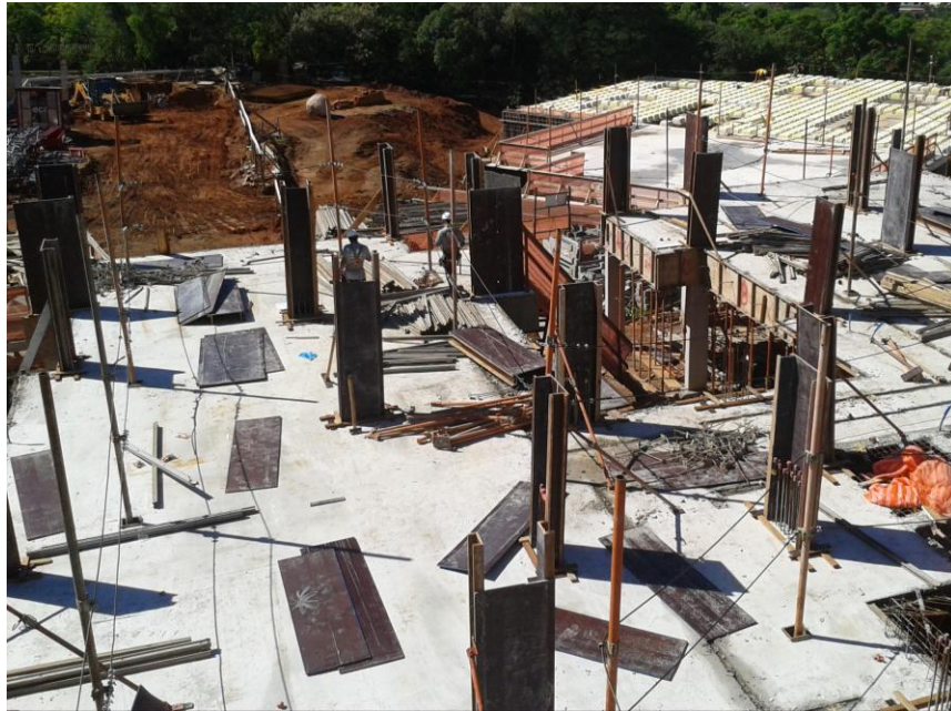
Figura 31 – Posicionamento dos pilares
