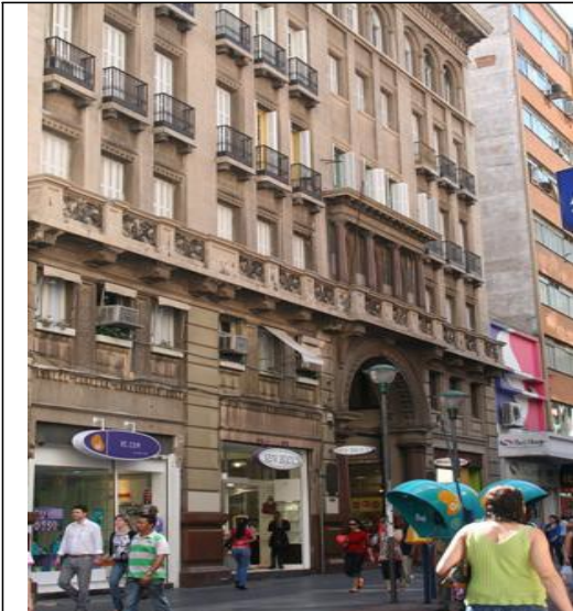
Foto 4: Fachada da Galeria Chaves antes da revitalização Fonte: O autor
