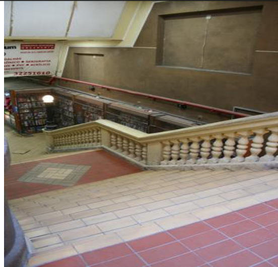
Foto 12: Escadaria de acesso entre Rua José Montauray e Rua dos Andradas Fonte: O autor
