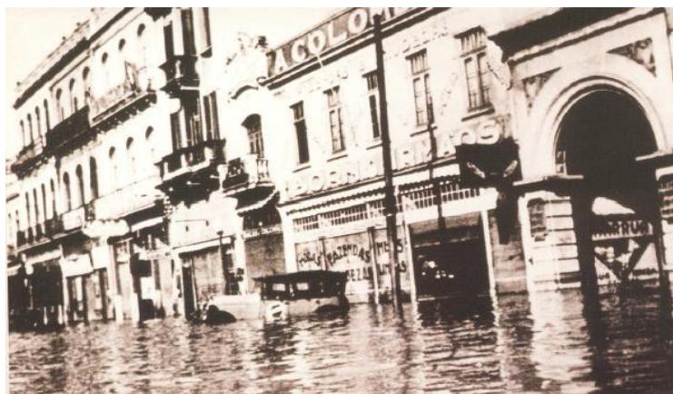
Foto 3: foto da passagem da Galeria Chaves na enchente de 1941
