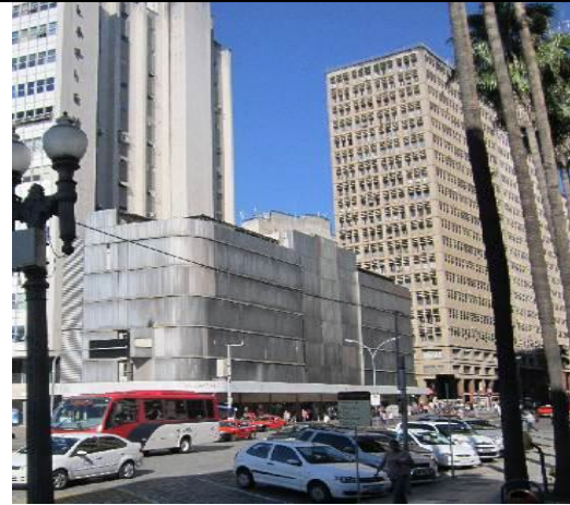
Foto 2: Fachada do edifício Guaspari na atualidade Fonte: O autor.
