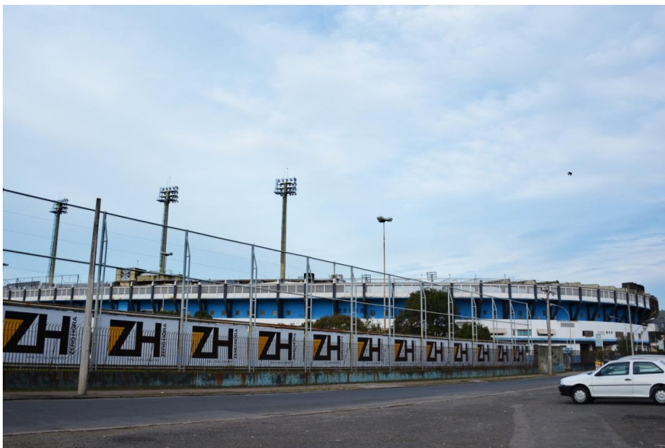
Figura 13: Estádio Olímpico Monumental, já em fase de demolição.
