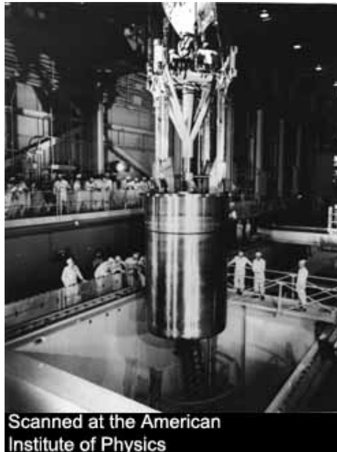
Figura III.2 – Vaso de pressão do reator de Shippingport, [ESVA, 2007].
