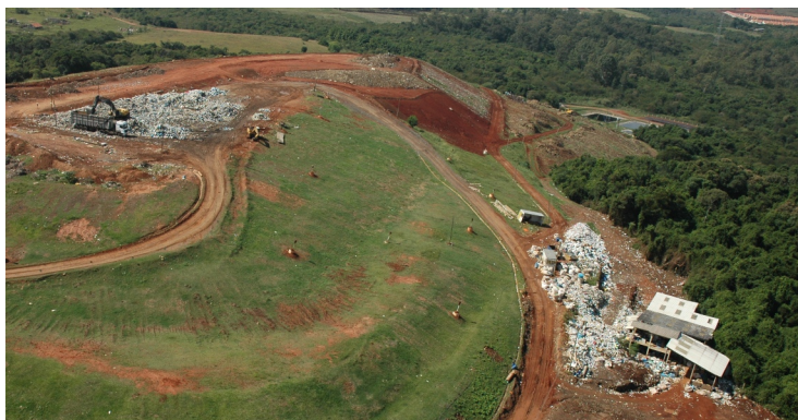
Figura 14 – Aterro operando como estação de transbordo.
