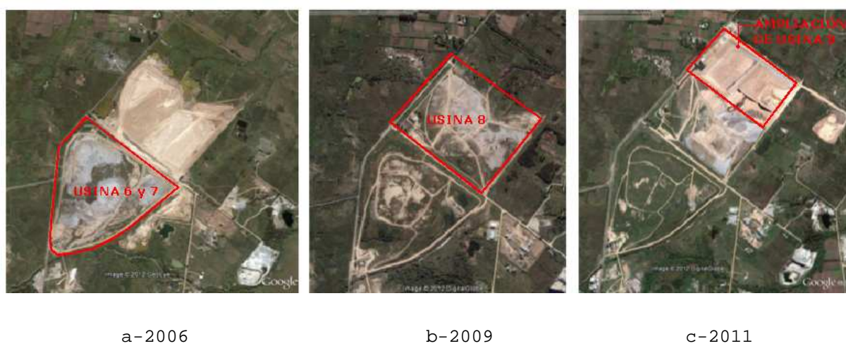
Figura 60. Depósito de resíduos sólidos urbanos.
