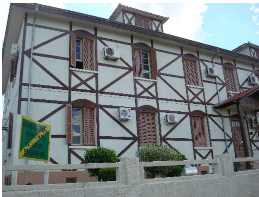
Imagem 22 – Prédio da prefeitura de Pareci Novo. 67
