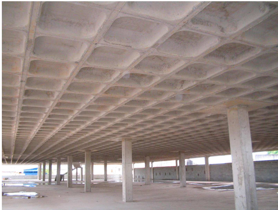
Figura 1: Estrutura em laje nervurada de concreto armado
