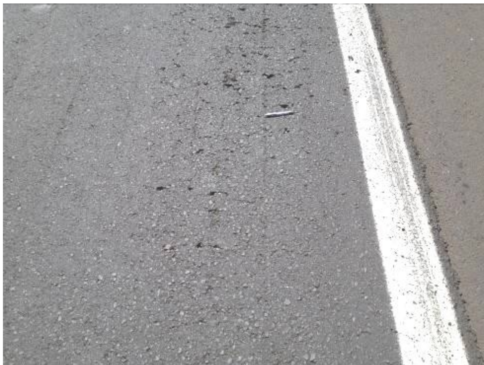
Figura 119. Arrancamento dos agregados da mistura asfáltica nos trechos monitorados, após 2 anos de tráfego
