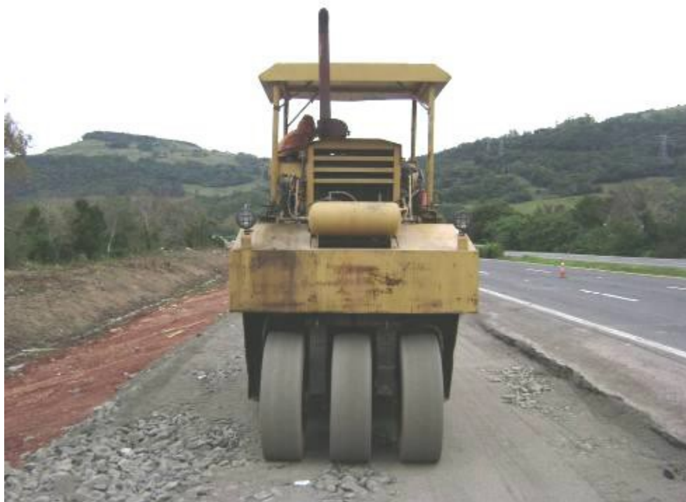
Figura 51. Compactação do Macadame Seco no trecho I
