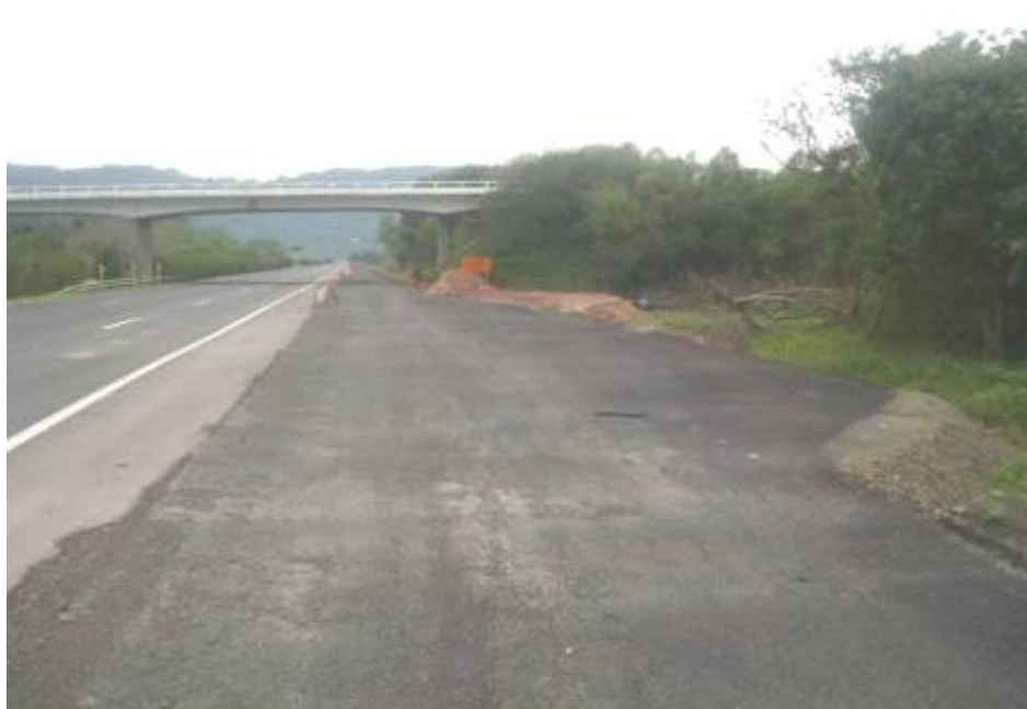
Figura 53. Primeira camada de revestimento asfáltico na faixa de ampliação da rodovia no trecho II
