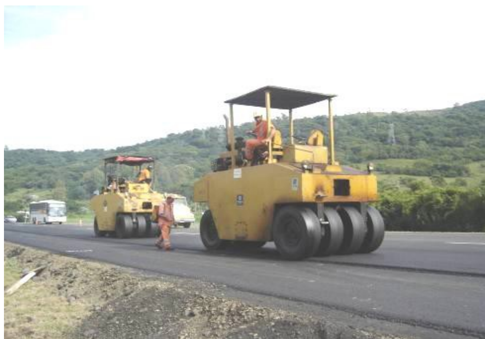
Figura 57. Compactação da camada de revestimento asfáltico
