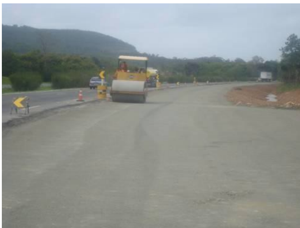
Figura 52. Camada de Base com Brita Graduada
