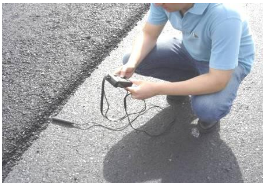
Figura 56. Controle da temperatura da mistura antes de concluída a compactação
