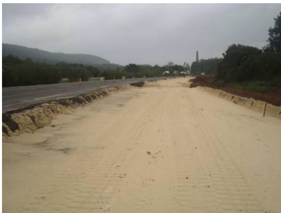
Figura 49. Execução do reforço em areia no trecho I
