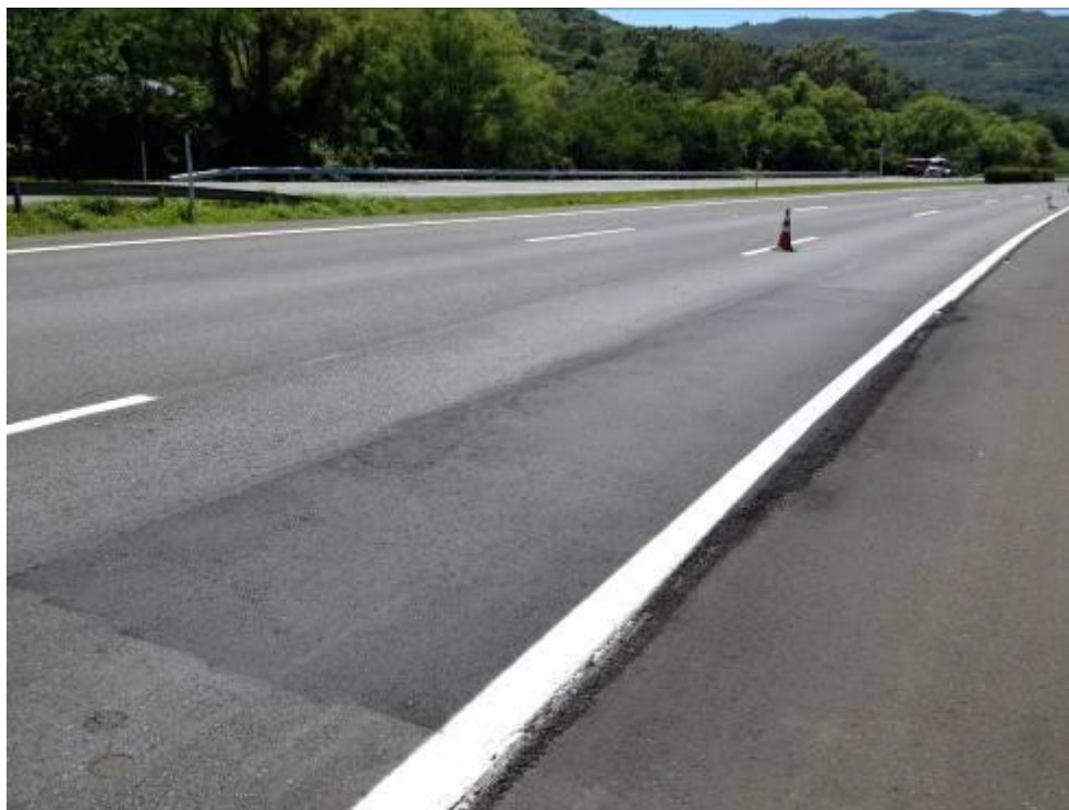
Figura 121. Remendo superficial no trecho monitorado I
