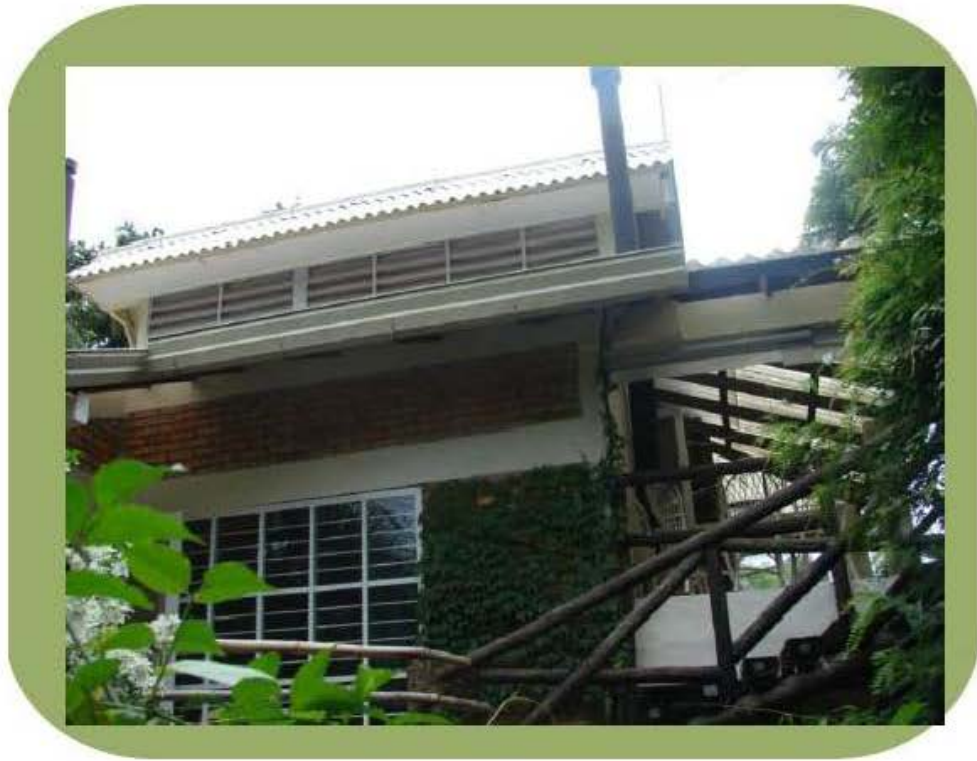
Figura 1. Casa Energias Renováveis fachada
