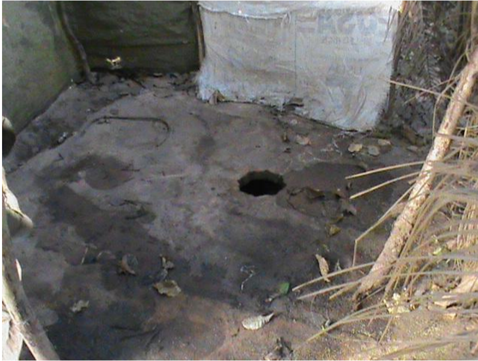
Figura 14 – Banheiro de uso coletivo.
