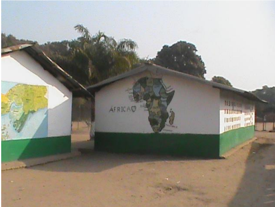
Figura 12 - Pavilhões de sala de aula.
