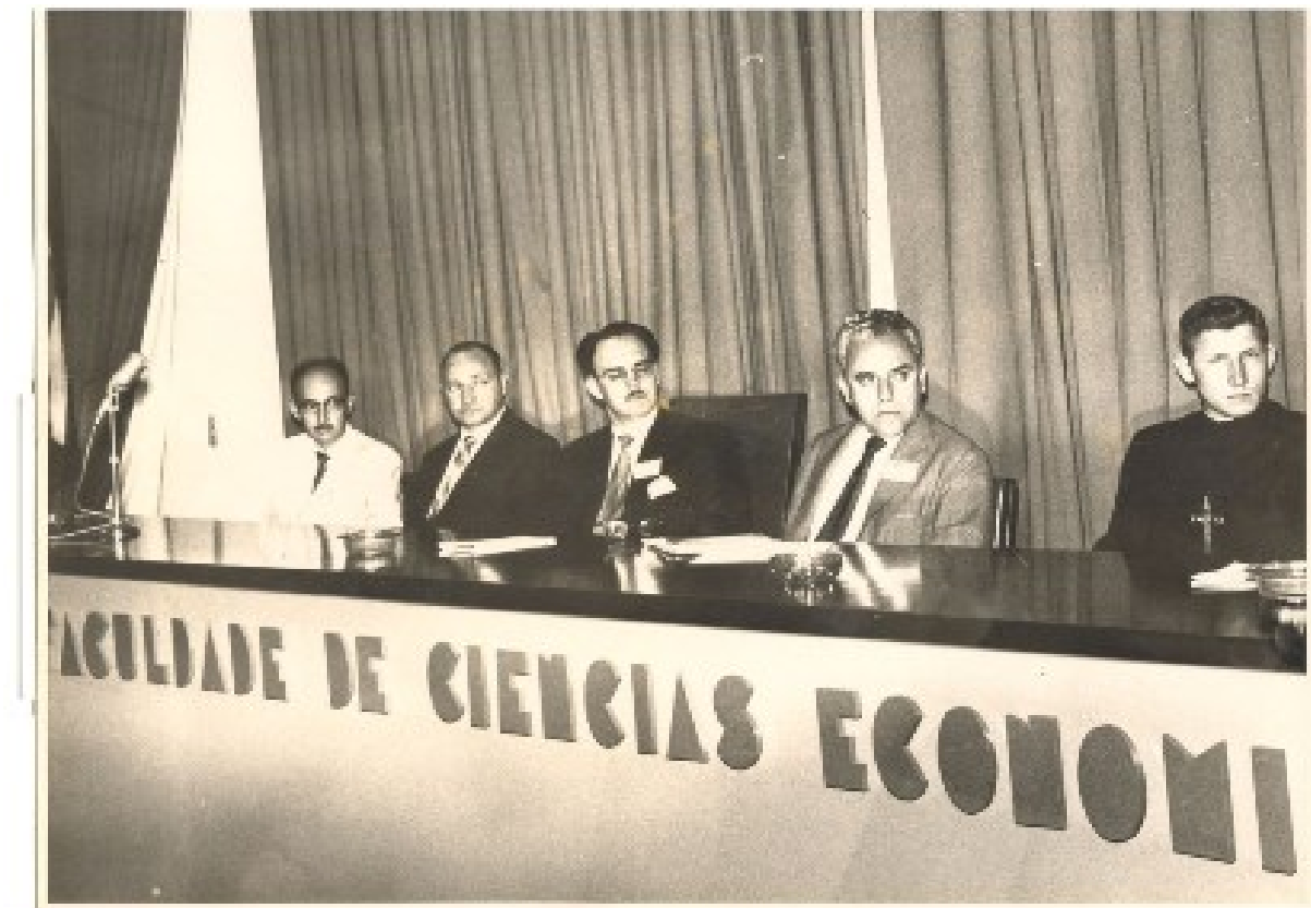
Auditório da Faculdade de Ciências Econômicas da UFRGS. Fonte: IHGRS.
