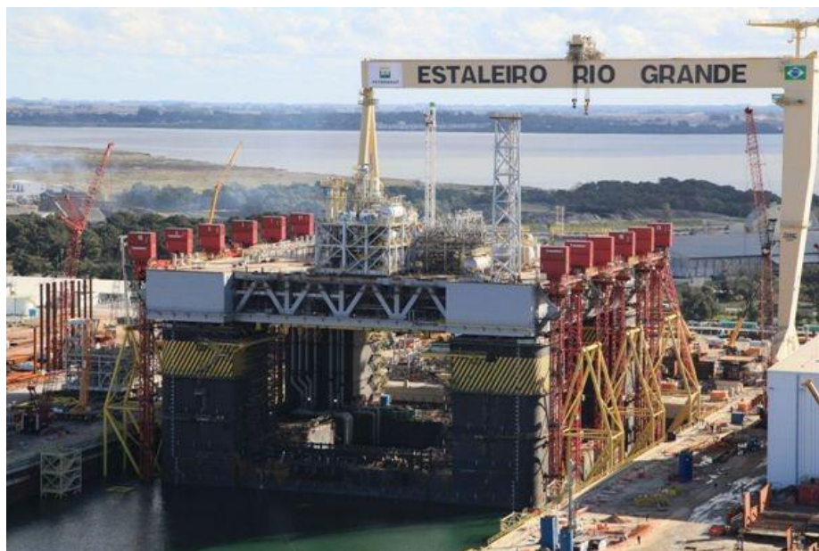
Foto 1 – Construção da Plataforma P-55 no Polo Naval de Rio Grande
