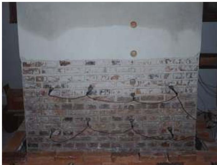
Figura 16: Face da parede com o cátodo já instalado no corte da alvenaria com o revestimento já recomposto (RUARO, 1997)
