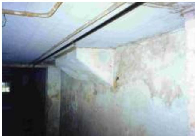
Figura 31: umidade na parede lateral do porão abaixo da lareira
