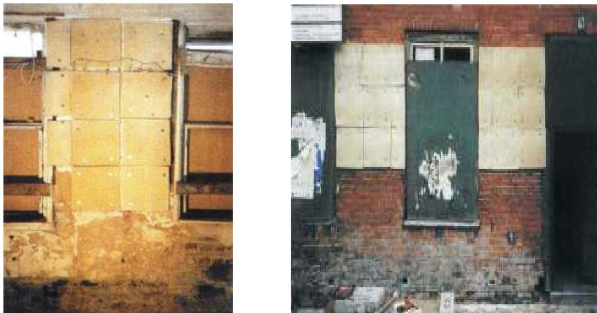
Figura 10: mantas de celulose aplicadas em ambas faces de uma parede com umidade e salinidade (interna e externa) em uma casa na Alemanha (VENZMER, 2000)
