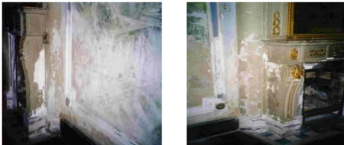
Figura 30: desagregação da argamassa interna à esquerda e à direita da lareira da casa respectivamente
