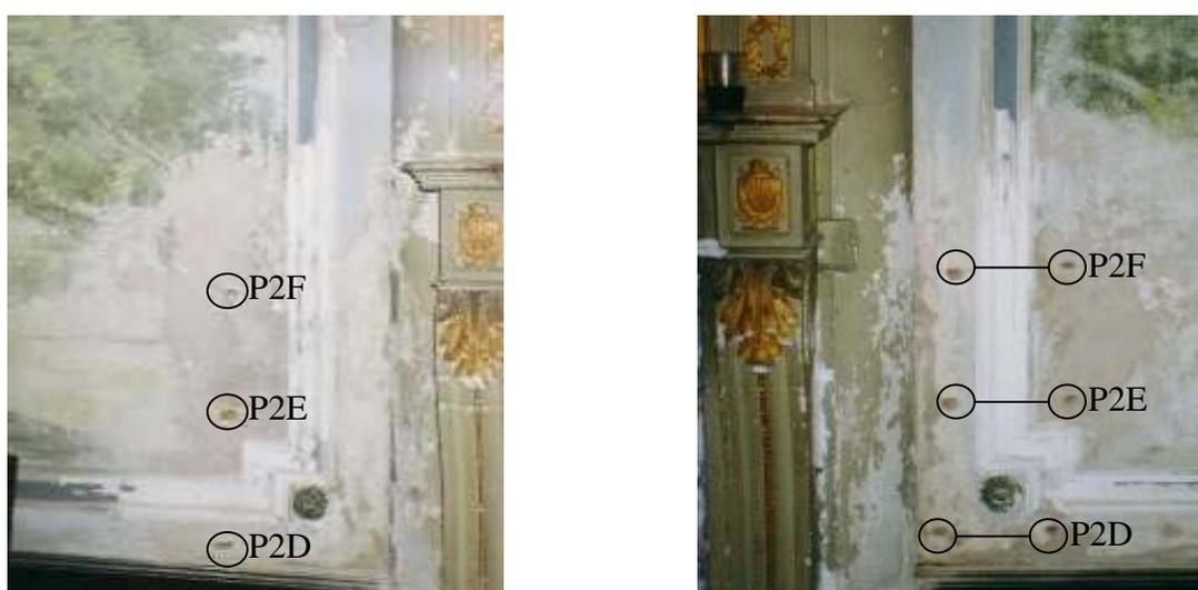
Figura 54: posição de retirada de amostras no 1º piso da casa, à esquerda e à direita da lareira respectivamente
