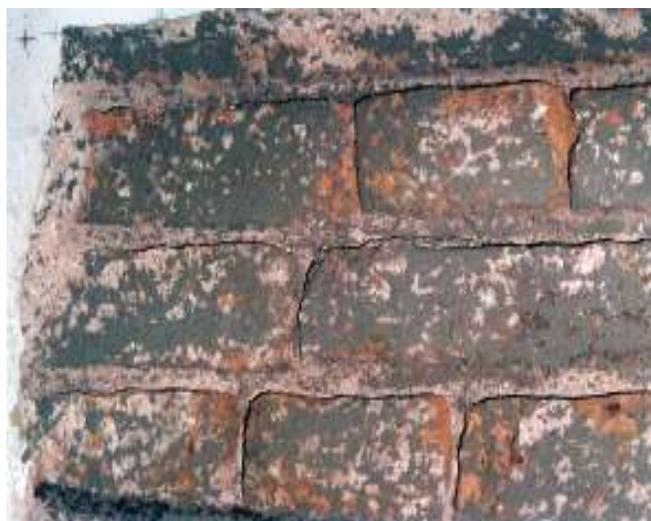
Figura 65: painel com juntas raspadas entre os tijolos
