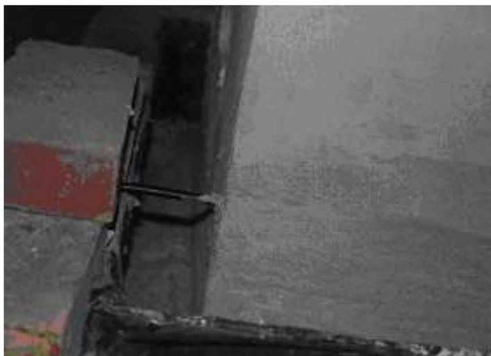
Figura 15: face da parede com as duas linhas de eletrodos e à direita o perfil vertical de furos devido à retirada de amostras contaminadas (RUARO, 1997)
