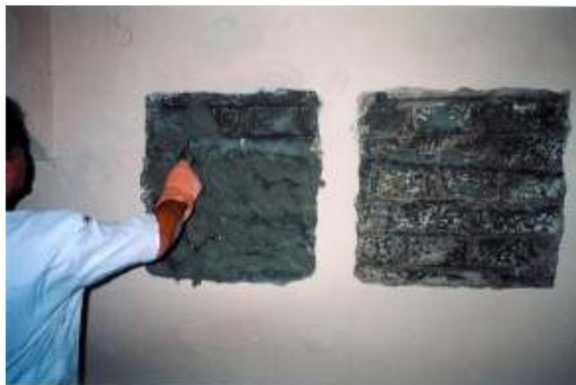
Figura 67: aplicação dos traços 1:2:9 sem aditivos e 1:2:9 com aditivos na parede do porão
