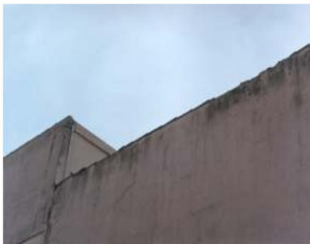
Figura 32: platibanda lateral com manchas escuras e argamassa de revestimento com fissuras sob forma de pés-de-galinha
