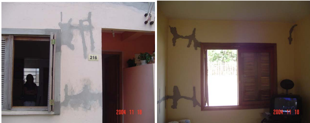
(a) (b) Figura 22(a e b): recomposição da parede devido a fissuras que a atravessaram junto à janela no condomínio Renascer
