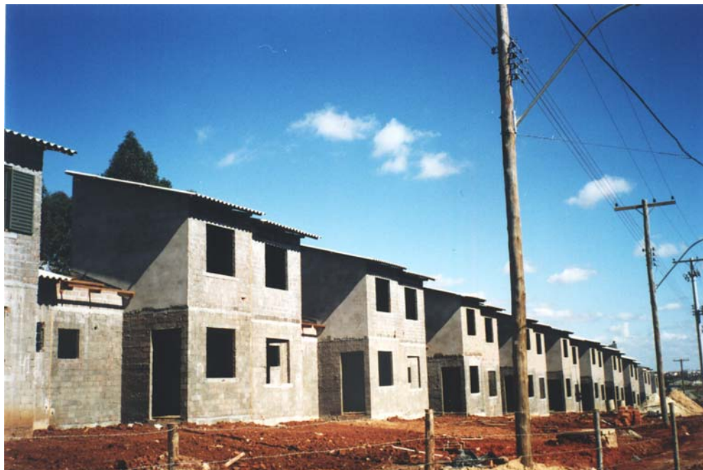
Figura 35: execução do revestimento externo do condomínio Costa e Silva.
