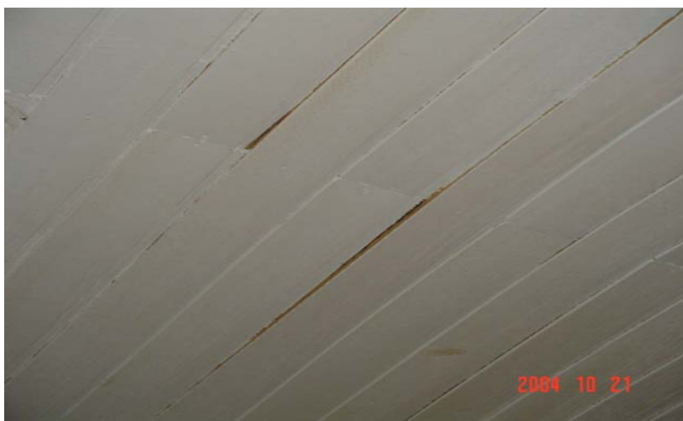
Figura 55: deformação de forrinho. Condomínio Dona Eugênia.
