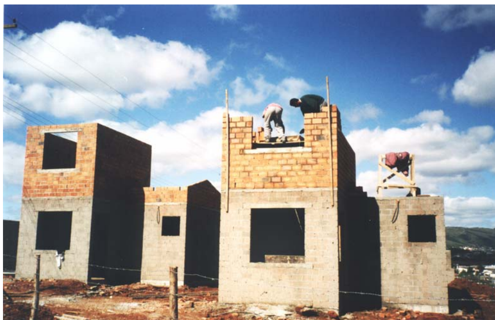
Figura 16: execução das alvenarias do condomínio Costa e Silva (arquivo DEMHAB)
