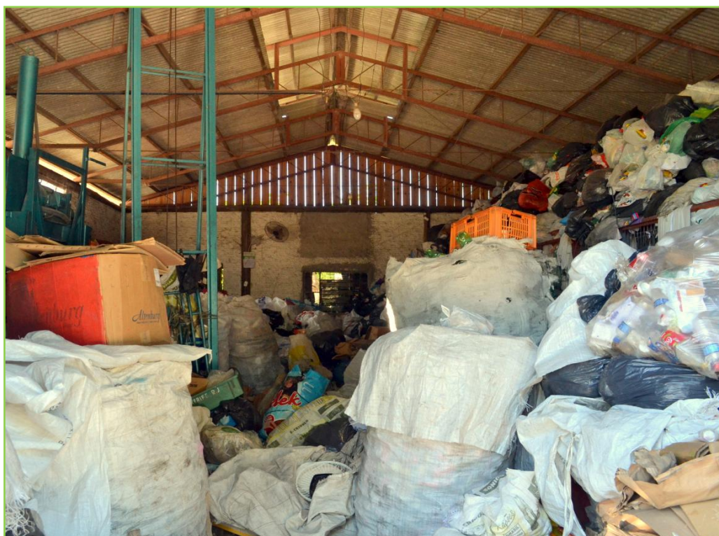
Figura 48 – Galpão da Associação Vitória repleto de Resíduos Sólidos, inadequado para o Trabalho (Rio Grande/RS, 13/02/2012). Registrada pelo Autor.
