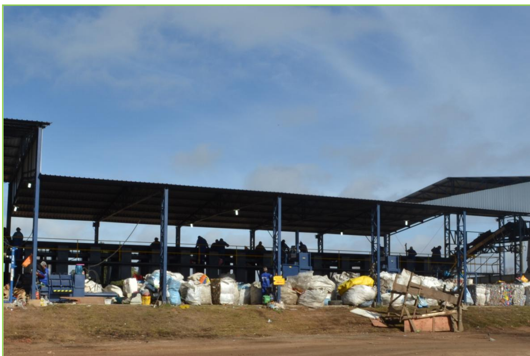
Figura 57 - Estrutura da Usina de Triagem onde trabalha a Cooperativa Santa Rita (Rio Grande/RS, 06/08/2012). Registrada pelo Autor.
