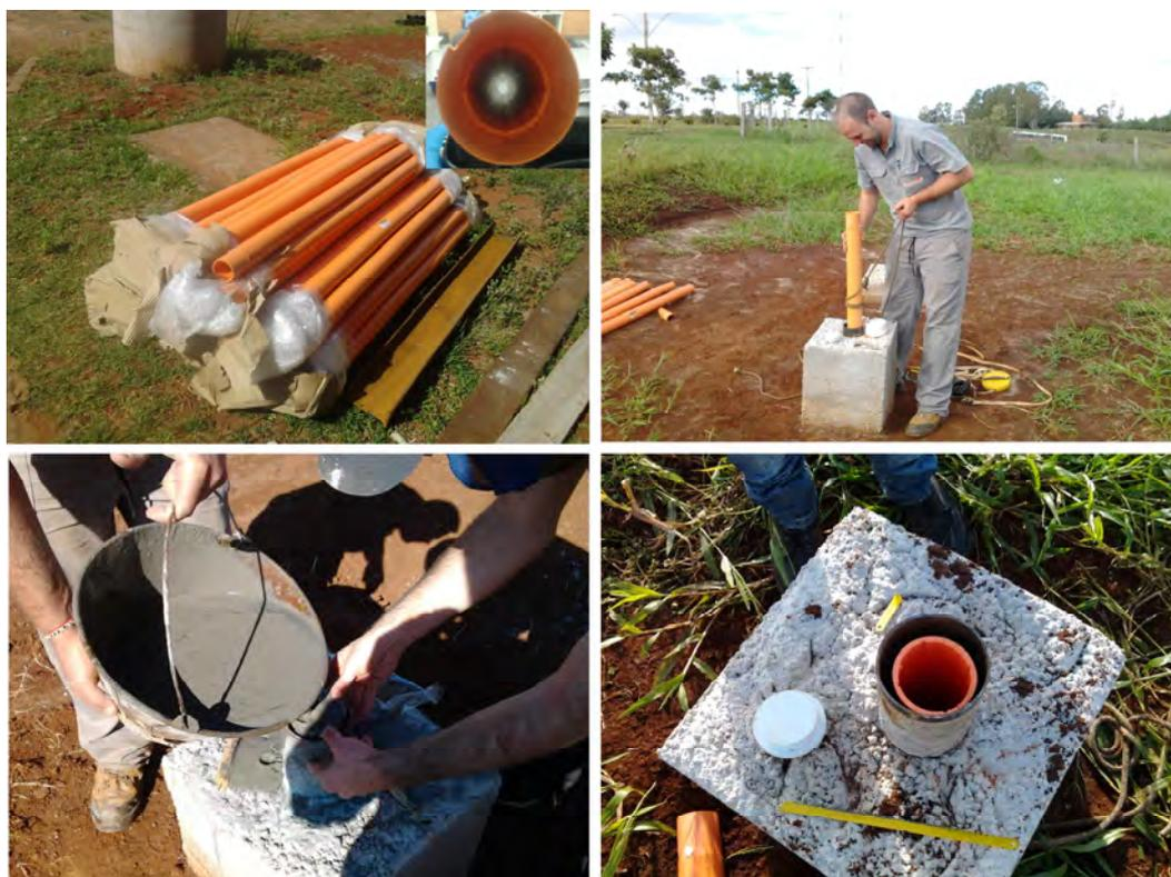
Figura 6.25 – Pormenor da instalação dos tubos de inclinômetro, incluindo a calda de cimento.
