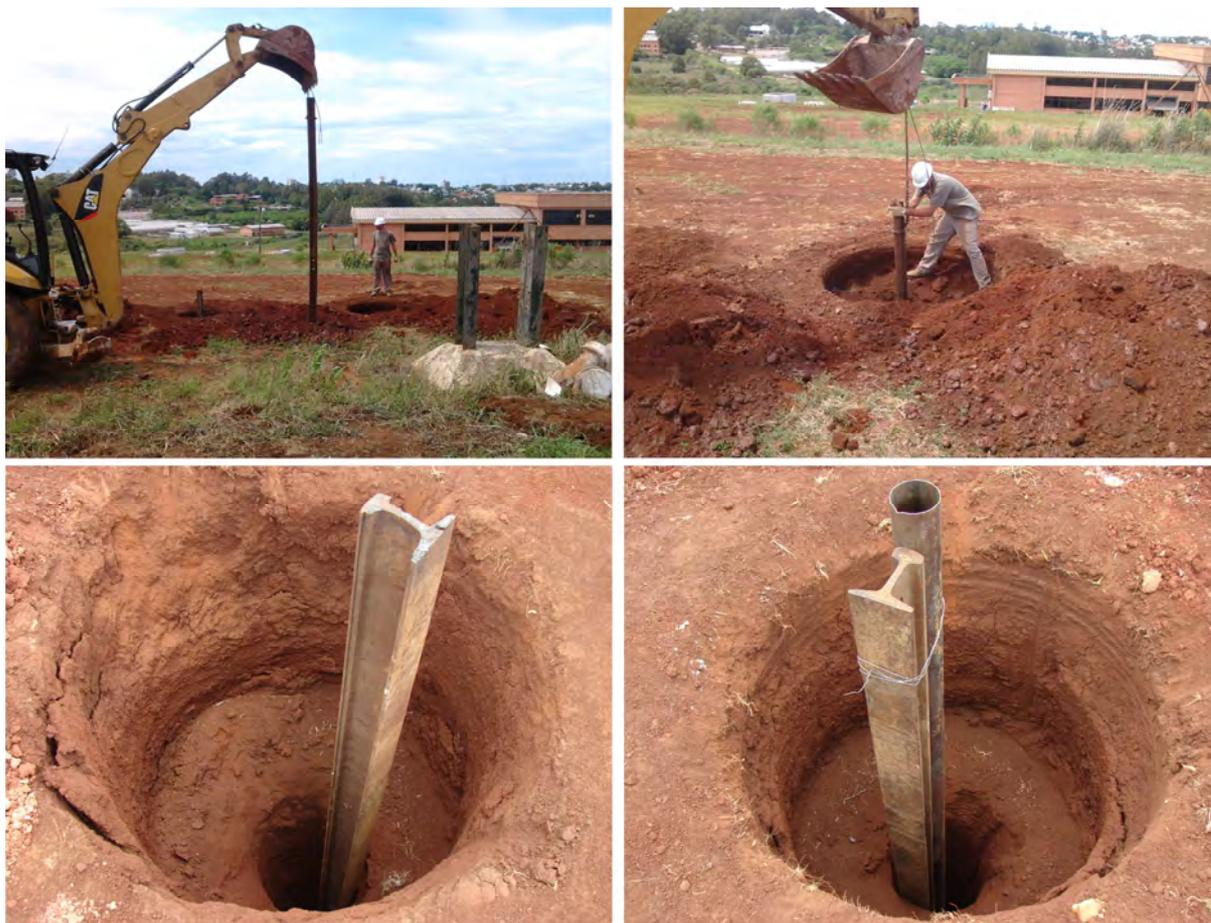
Figura 6.22 – Inserção das armaduras dentro dos furos.
