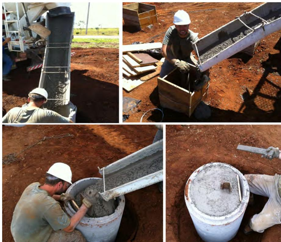
Figura 6.23 – Concretagem das estacas.
