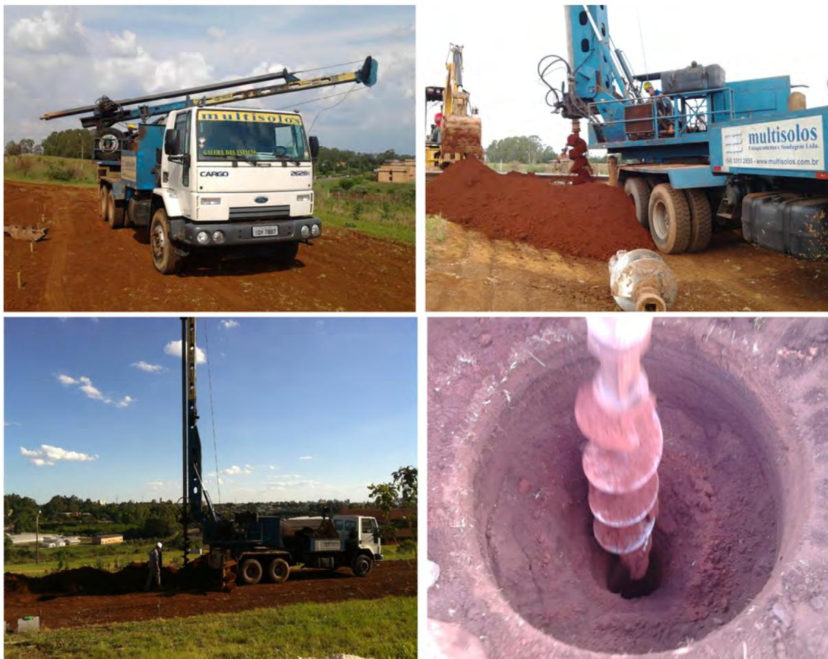
Figura 6.21 – Execução da escavação das estacas com trado rotativo.
