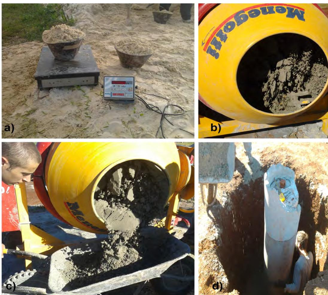
Figura 6.34 – Execução e transporte da mistura de solo cimento, sua (a) pesagem de materiais, (b) homogeneização, (c) transporte e (d) despejo na cava.
