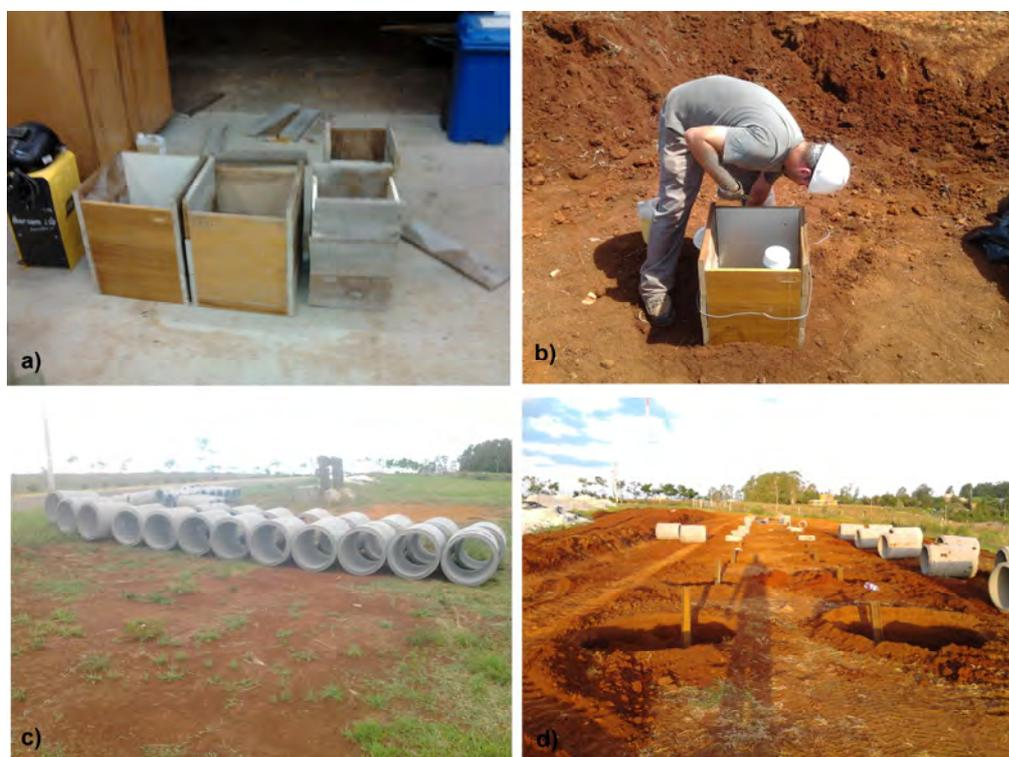
Figura 6.24 – Formas utilizadas para o concreto (a) e (b) nas estacas em solo natural, e (c) e (d) em estacas que iriam receber o solo cimentado.
