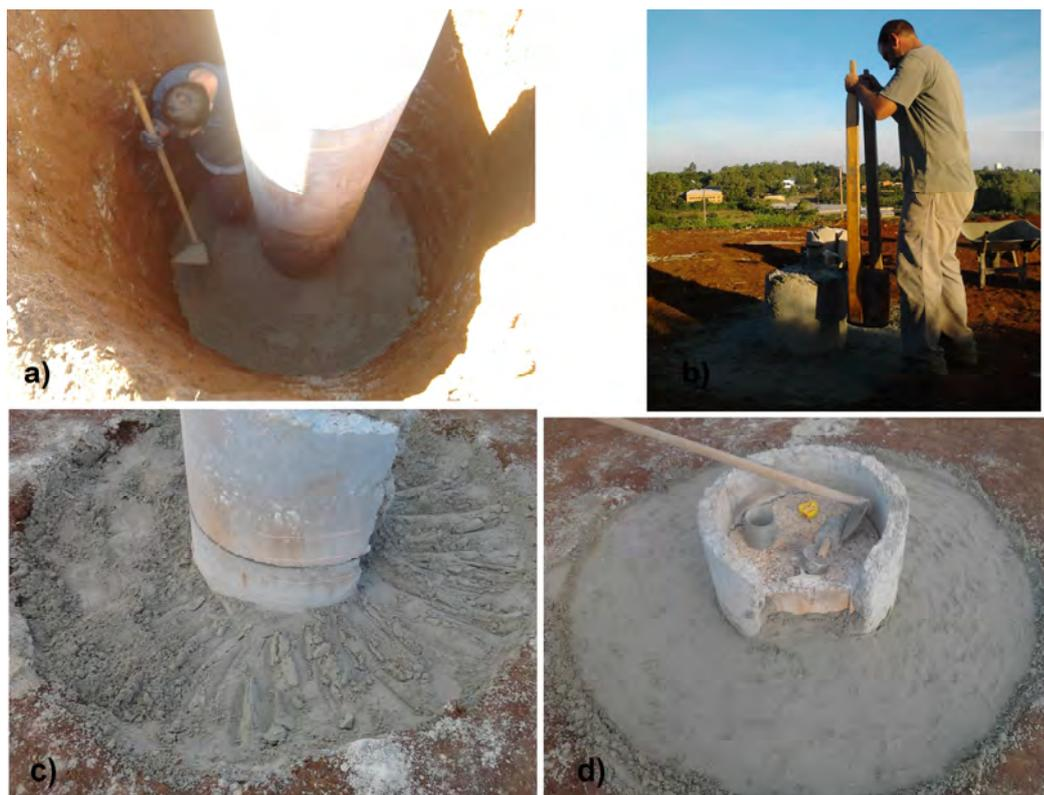
Figura 6.35 – Execução da compactação da mistura de solo cimento, com (a) o seu espalhamento e pré-compactação, (b) compactação com soquete manual, (c) escarificação e (d) aspecto final.
